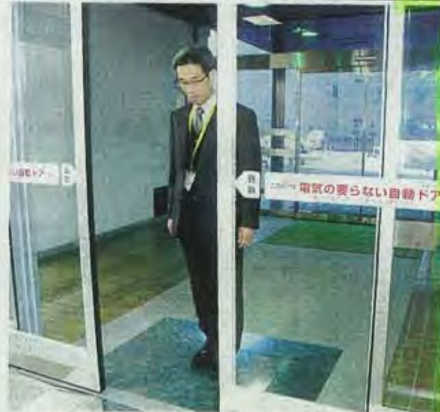
柏崎市ガス水道局に設置された無電源式自動ドア＝柏崎市鏡町
