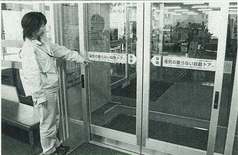
電気を使わず、利用者の体重で開閉する市ガス水道局の無電源式自動ドア
