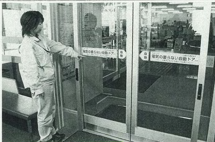
電気を使わず、利用者の体重で開閉する市ガス水道局の無電源式自動ドア
