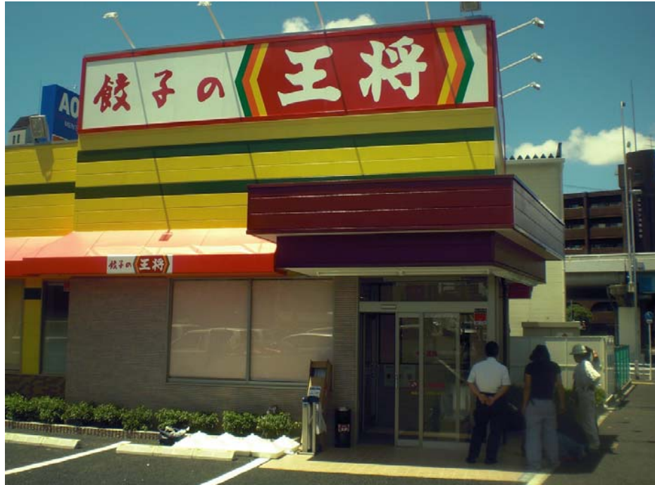
餃子の王将 大阪吹田春日店 施工中 2011,7,13 (7,18オープン)
