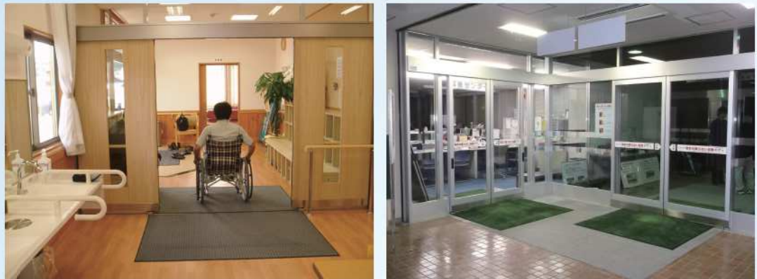
某デイサービス 公共施設入口
